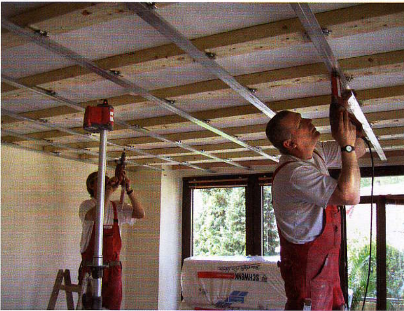
◀ Montage der Unterdecke mit dem Schienensystem Protaktor TPS 25
